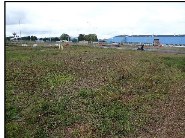
Photo 1A : Vues générales de la zone d'étude (Rainette, 2020)
